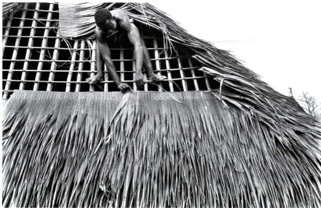
Pl. 7 Couverture d'une case. Les branches de palmier sont plus faciles à travailler que la paille mais sont peu résistantes. (1955)
