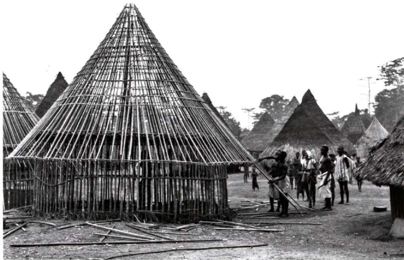
Pl. 6 Charpente d'une case. Le toit est couvert de paille ou de branche de palmier, les murs sont crépis d'argile. (Janvier 1950)
