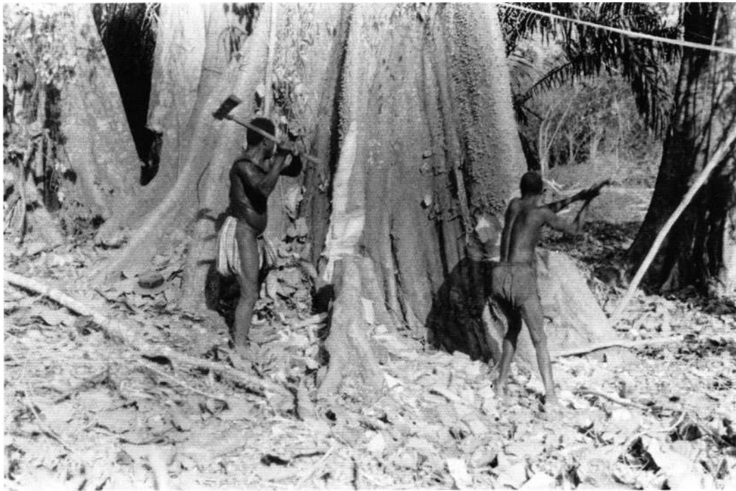
25 Verwendung der Axt zum Bäumefällen (hier Herausschla- gen einer Brettwurzel)
