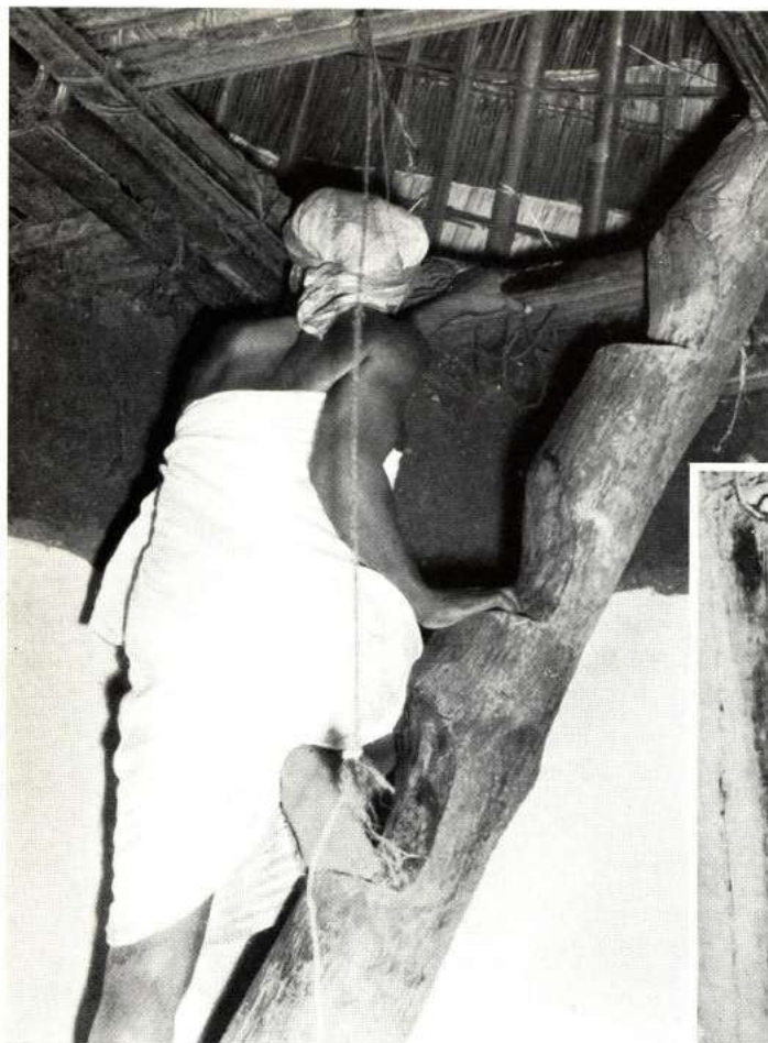
8a Blick in eine Dan-Hütte: Der Steigbaum, der zum Dachraum führt.
